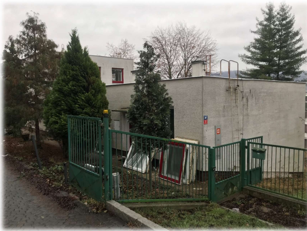
Obrázek 6 - Současný stav – západní pohled (vlastní foto)
