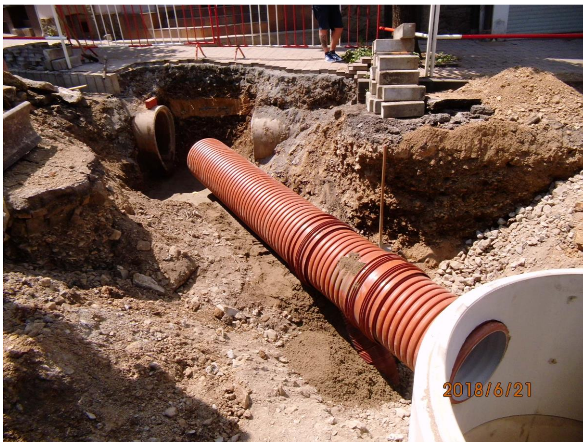
Obrázek 20 SO 301 napojení na stávající kanalizaci
