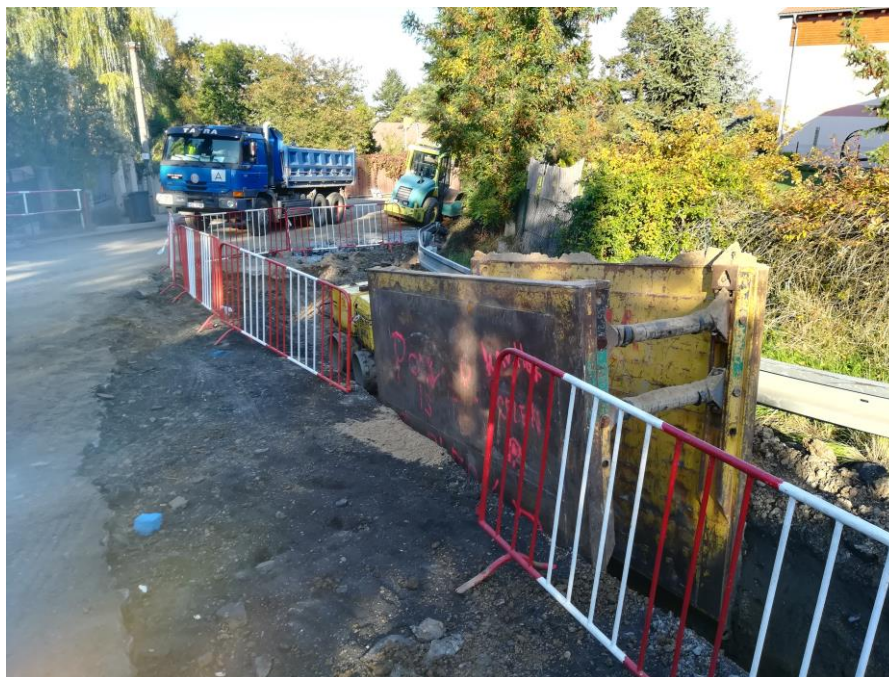
Obrázek 5 Pomocné konstrukce při zabezpečení výkopu
