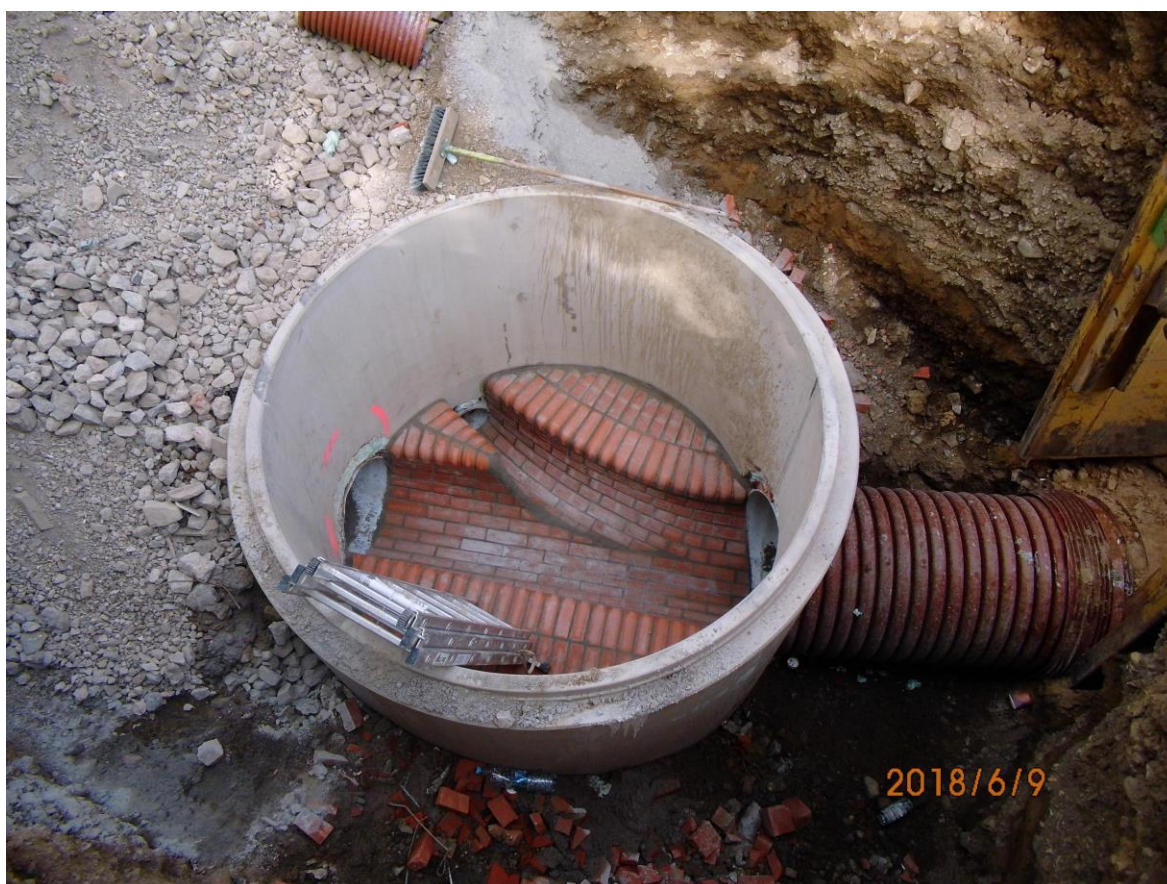
Obrázek 9 Spojná komora SO 301
