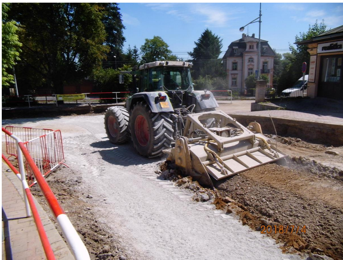
Obrázek 21 Zlepšování zeminy DOROSOLEM
