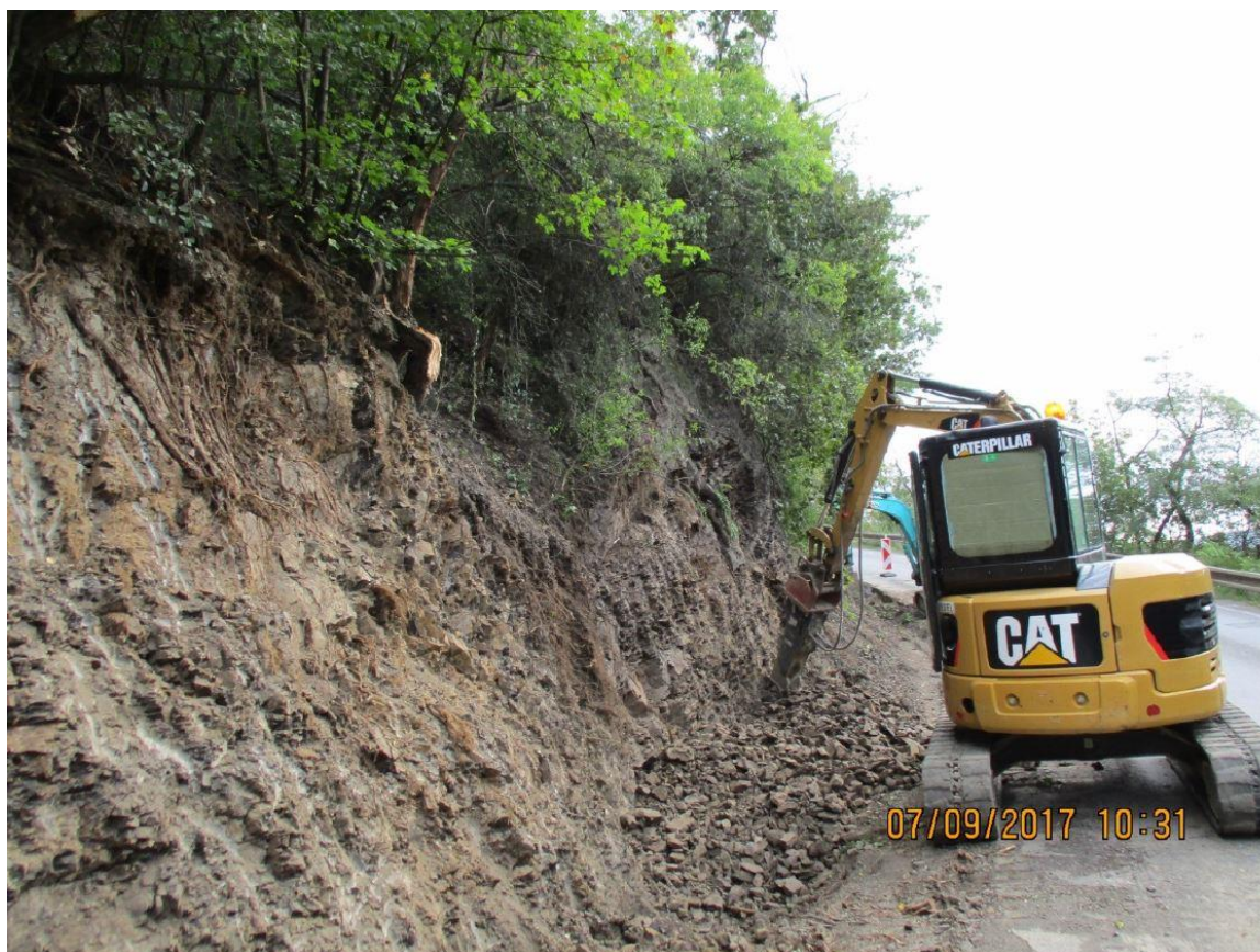
Obrázek 18 Hornina třídy těžitelnosti II.
