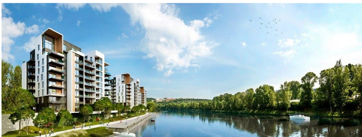
Obrázek 11 – Bytový komplex Marina Island (zdroj: (25))
