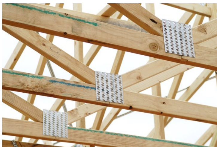
obr. 1 Charakteristický styčník systému GANG-NAIL [5]
