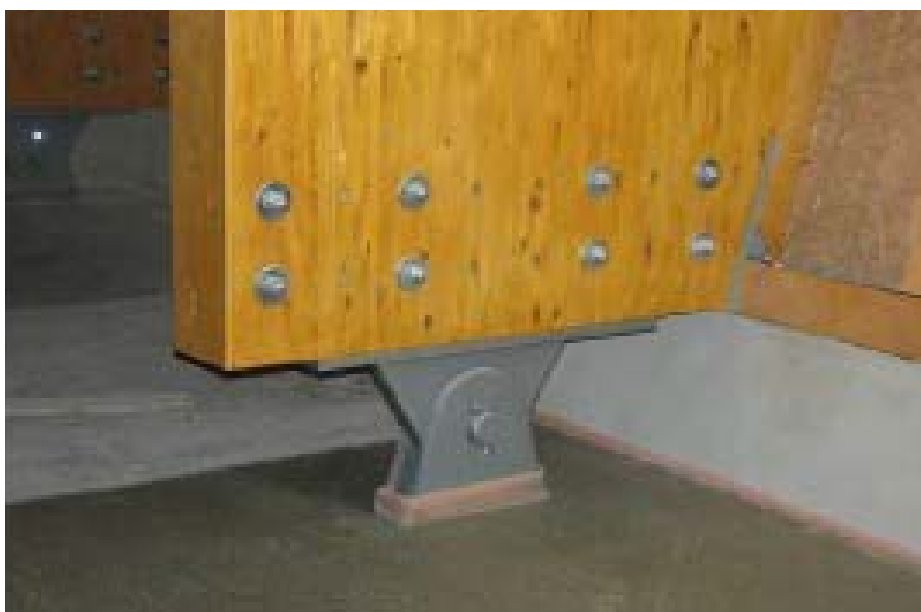
obr. 7 Detail podepření zakřiveného rámu na betonovou konstrukci [6]
