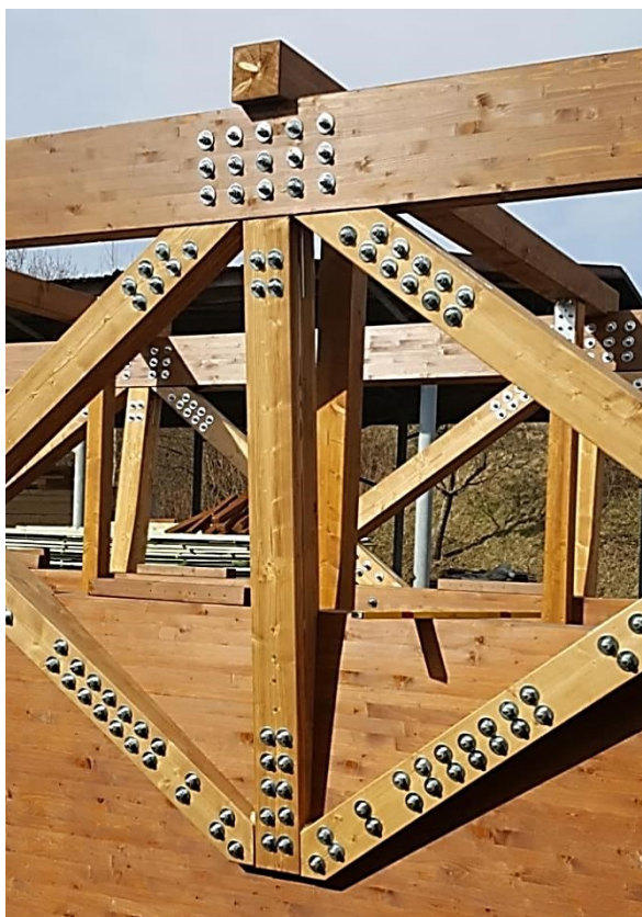
obr. 10 Styčníky příhradové soustavy s vkládanými plechy [13]
