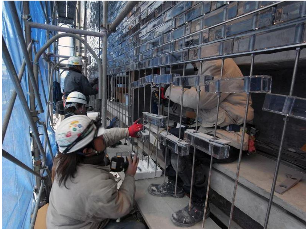
obr. 24: Zdící prvky zavěšené na závitové tyče [31]
