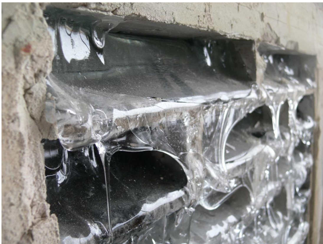
obr. 31: Detail stěny z vnitřní strany po požární zkoušce [32]
