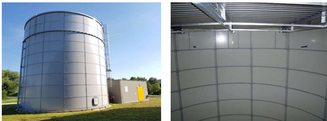
obr. 17 – Šroubovaná ocelová nadzemní nádrž – pohled zvenku a zevnitř (zdroj: kohimex.cz)
