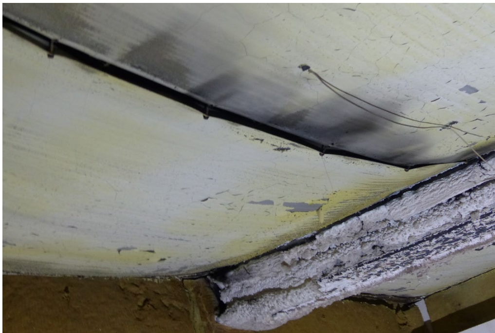
obr. 27 Pohled z pece na nosník a sendvičové panely po zkoušce
