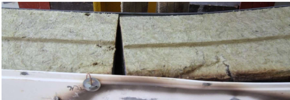
obr. 74: Detail jádra sendvičového panelu SPA 230E po experimentu – 600 °C
