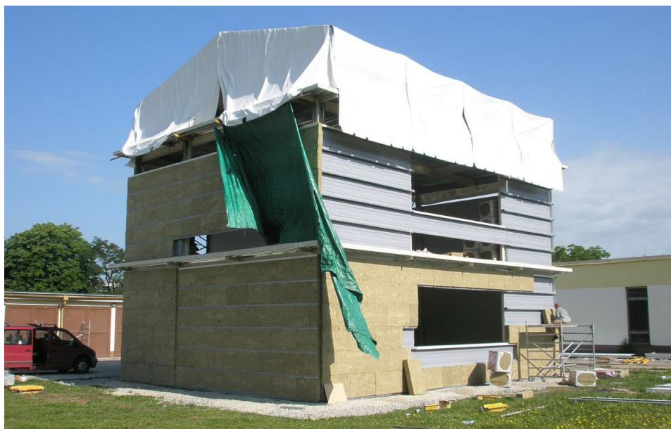
obr. 28 Zkušební objekt během výstavby
