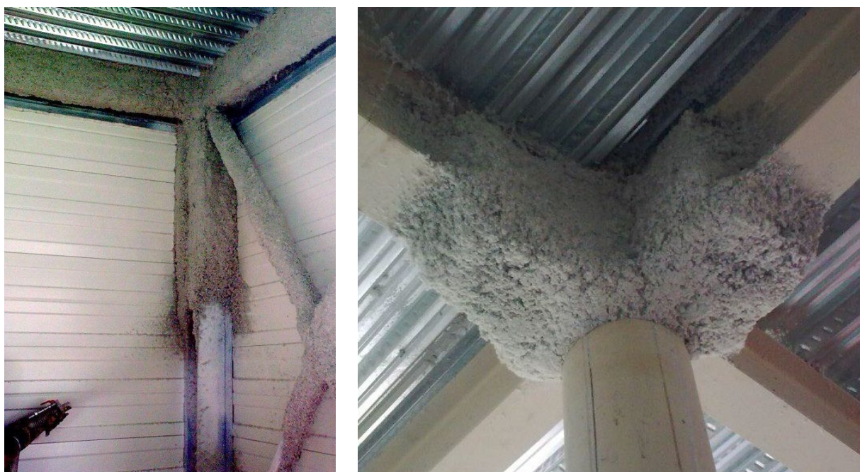
obr. 29 Aplikace protipožárního nástřiku
