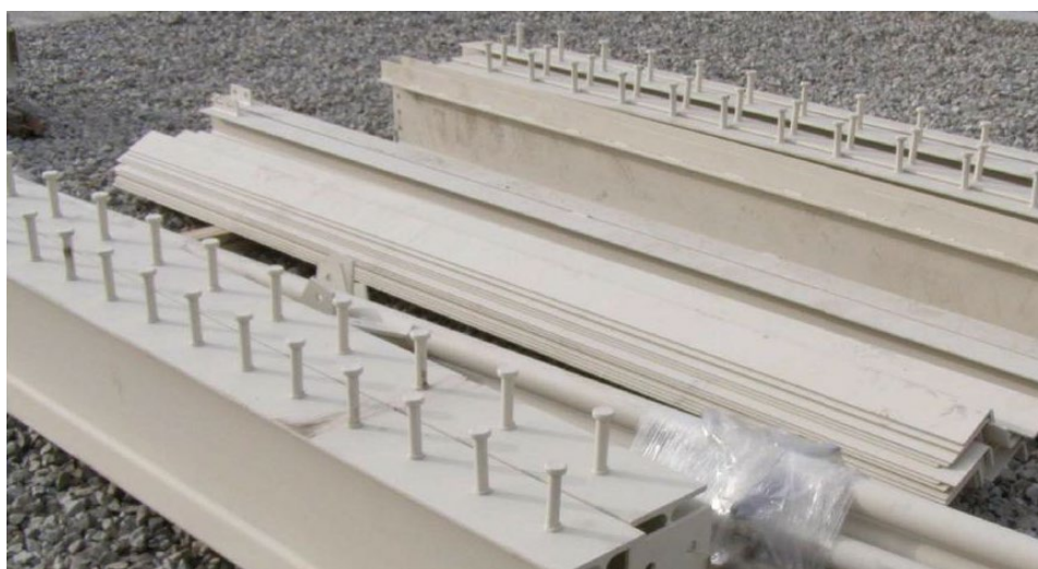
obr. 26 Použité ocelové nosníky se spřahovacími trny
