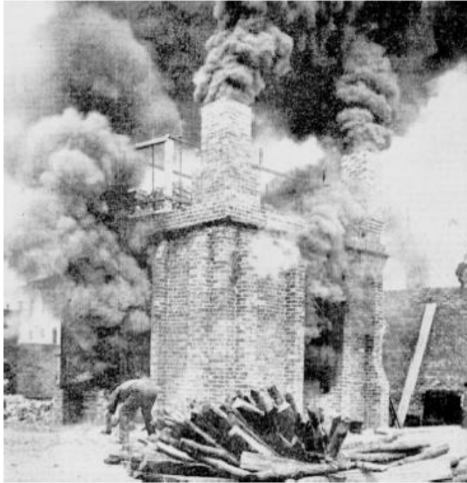
obr. 2 Zkouška požární odolnosti kolem roku 1902 [4]
