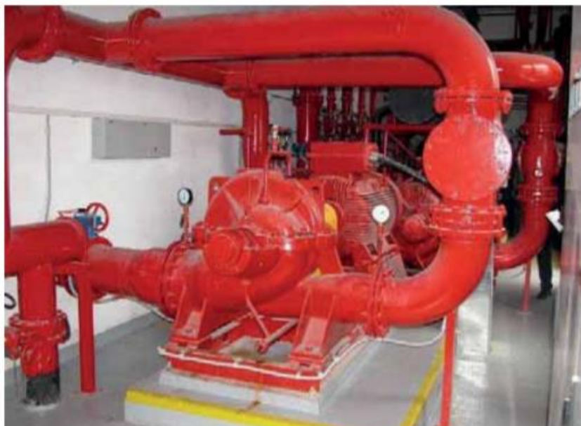
Obr. 15 Sprinklerové čerpadlo s elektromotorem [3]
