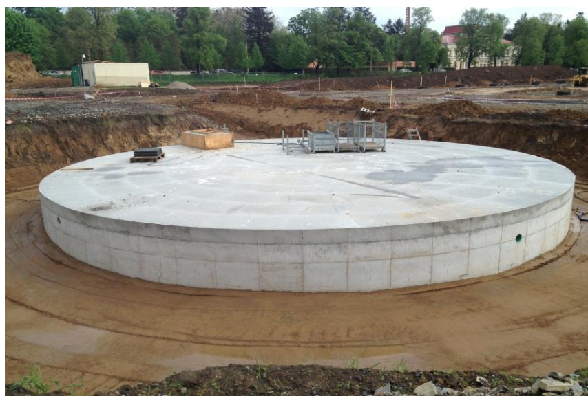
Obr. 18 Výstavba podzemní nádrže SHZ [11]
