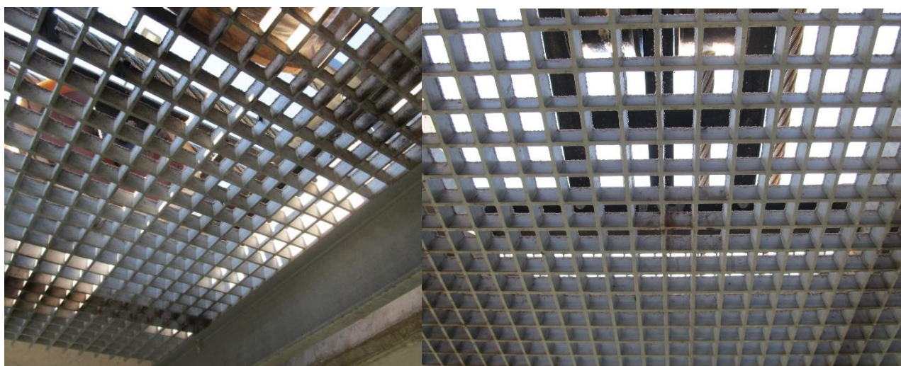
obr. 20 Použití pochozí roštu při renovaci lanové dráhy na Petřín (foto autora)
