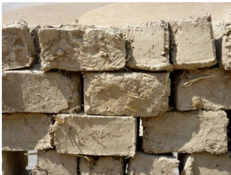
obr. 1 Hliněná cihla vyztužená slámou [3]
