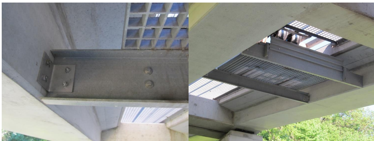
obr. 18 Použití protlačovaného profilu při renovaci lanové dráhy (foto autora)
