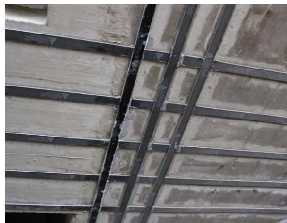
obr. 4 Aplikace uhlíkových lamel [6]
