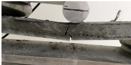
Obr. 43: Vodorovná trhлина – ztráta spolupůsobení s betonem
