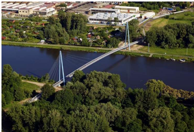
Obr. 3: Most v Čelákovících, převzato z [M. KALNÝ, J. KOMANEC, J. VÍTEK, V. KVASNIČKA, R. BROŽ, KOUKOLÍK, Petr a R. COUFAL, „LÁVKA PŘES LABE V ČELÁKOVICÍCH - PRVNÍ NOSNÁ KONSTRUKCE Z UHPC V ČR,“ BETON] [10]
