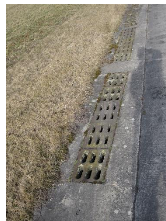
Odvodňovací systém vzletové a přistávací dráhy
