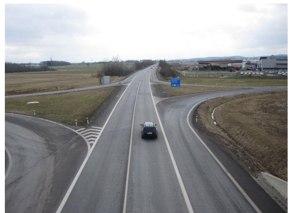
SDT AČR – pohled z mostu od severu
