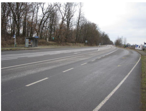
Rozšíření silnic zastávka Hluboká nad Vltavou, železniční stanice, rozcestí – pohled od severu
