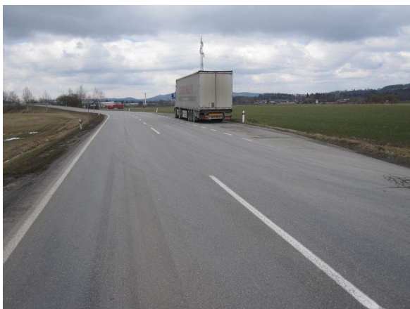
Evakuační trasa a KRS – pohled od východu
