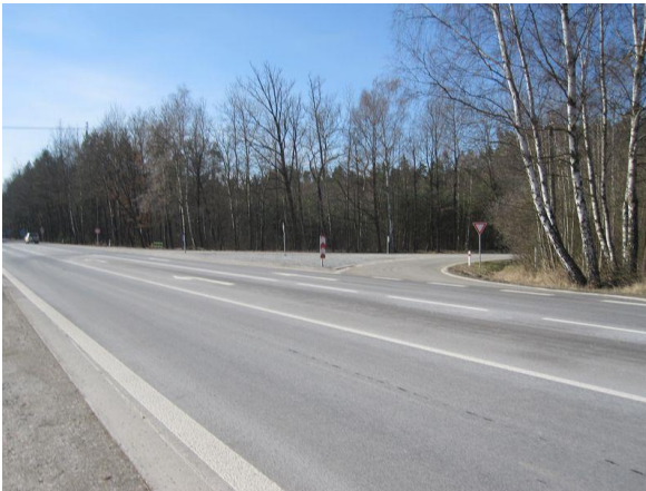
KRS pohled od severovýchodu
