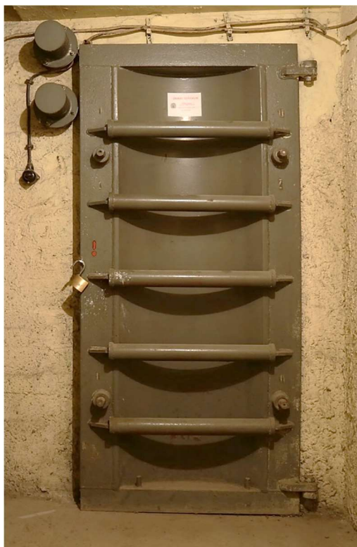
Obr. 1 – Tlakové dveře
