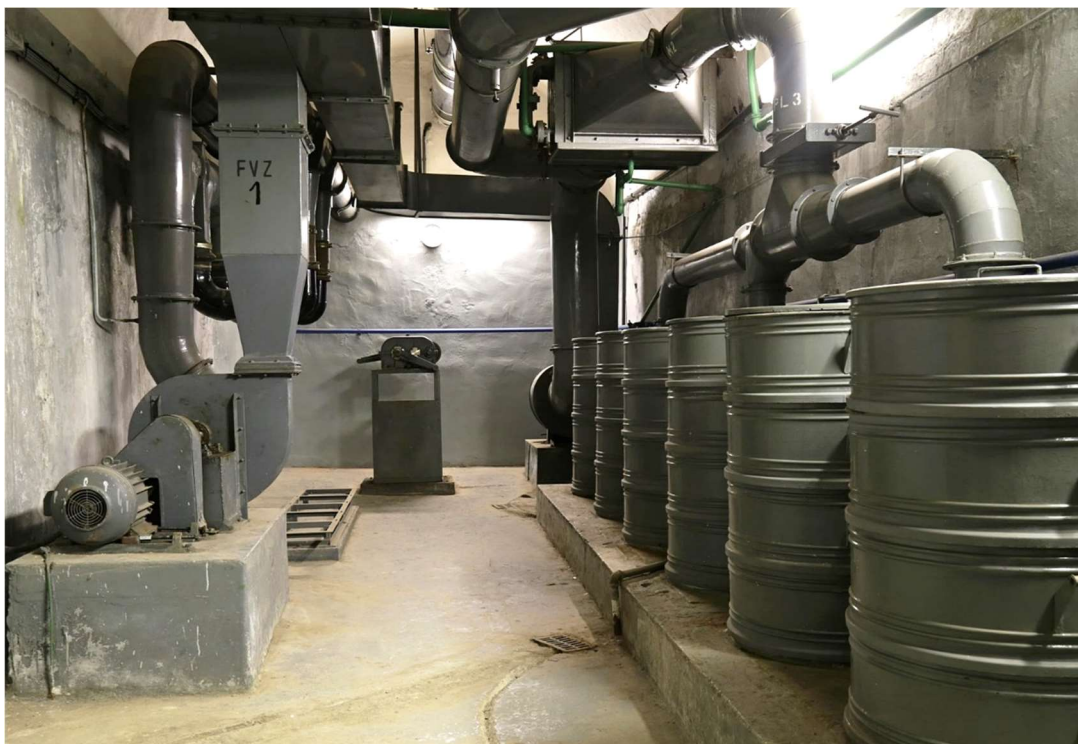
Obr. 4 – Filtroventilační komora
