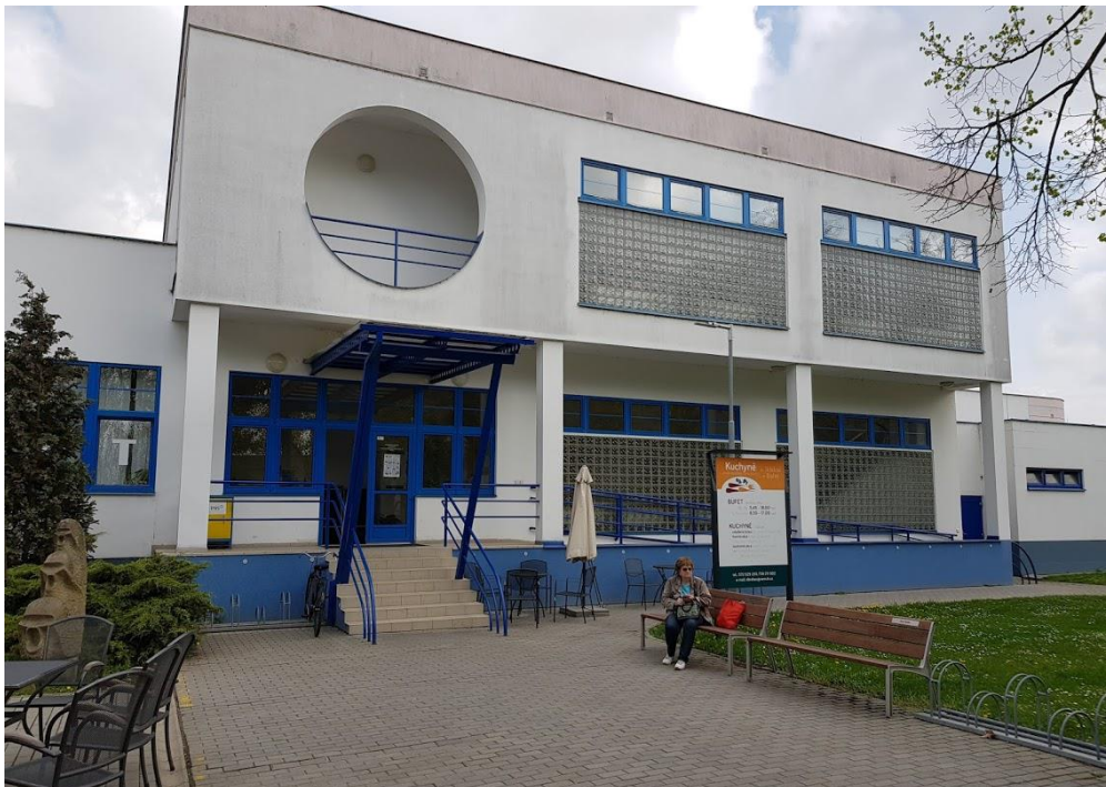
Obrázek 11 Budova Y která slouží jako kuchyně a bufet. [vlastní]
