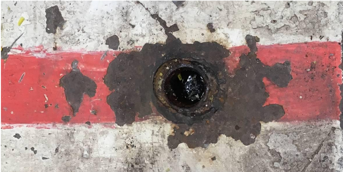
Obrázek 7 Futro pro vrtání branky shora (zdroj: Autor)
