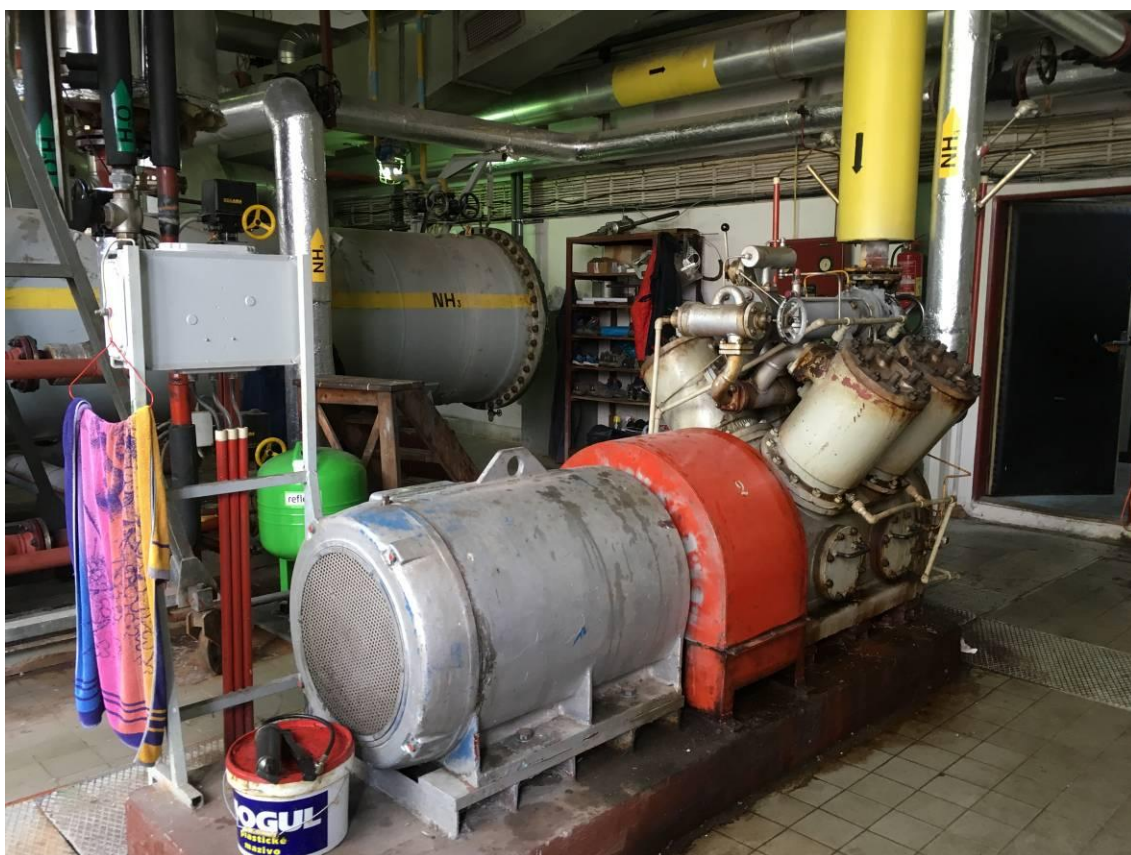
Příloha 6 Čpavkový kompresor, v pozadí sběrač čpavku Slaný (zdroj: Autor)
