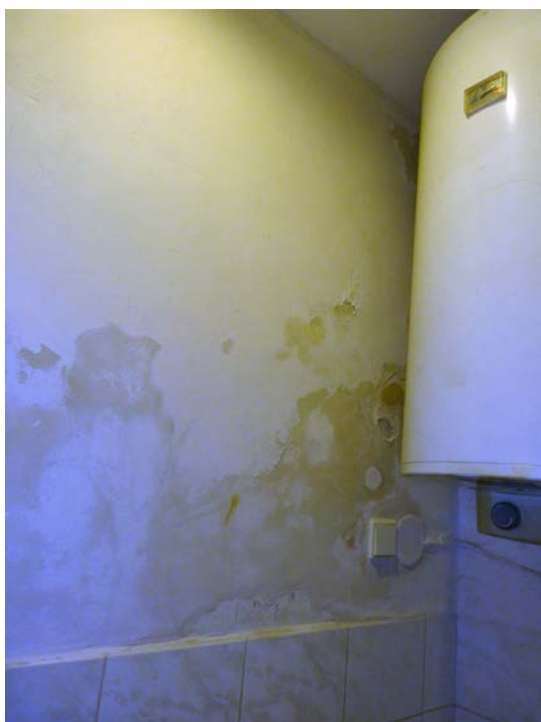
Obr. 21 Vlhkost v bytě 02 v přízemí v přístavku [4], Obr. 22 Vlhkost u východu do dvora [5]
