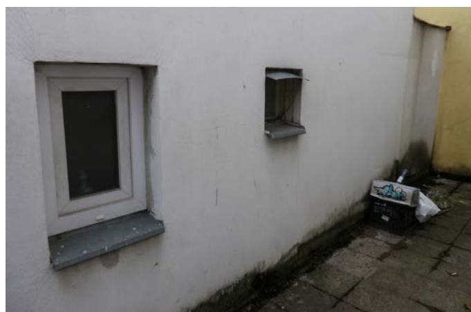
Obr. 23 Vlhkost na soukromé terase [4]
