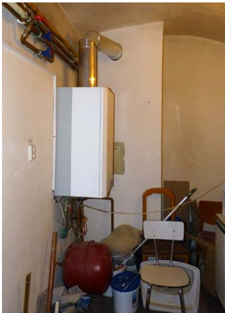
Obr. 19 Plynový kotel v 1NP [5]
