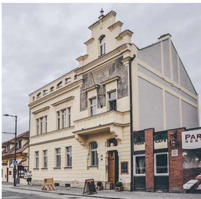
Obr. 3 Secesní vila po renovaci [9]
