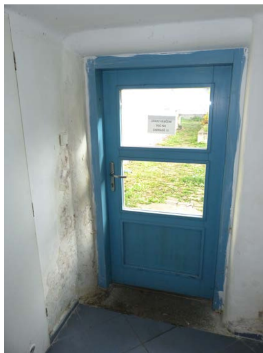
Obr. 21 Vlhkost v bytě 02 v přízemí v přístavku [4], Obr. 22 Vlhkost u východu do dvora [5]
