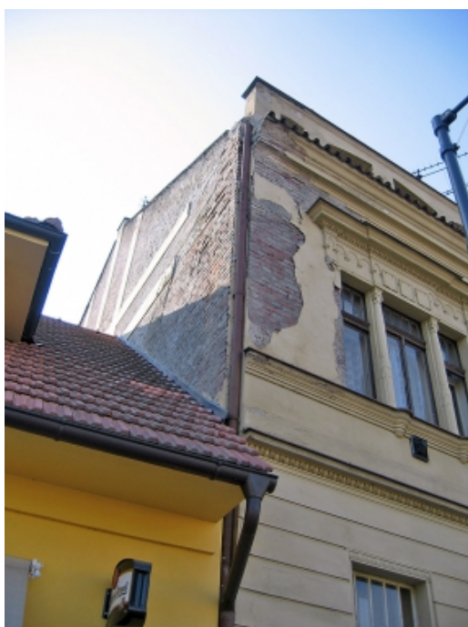
Obr. 2 Secesní vila před renovací [9]
