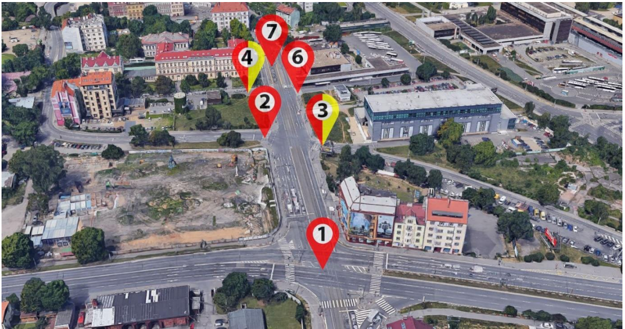
Obrázek 119 - Přehled rizikových míst (pohled na západ) 137
