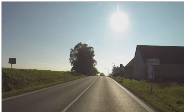
Obrázek 24: Žádná změna (úprava) charakteru komunikace (absence zklidňujícího opatření) I (staničení 144,888 km)
