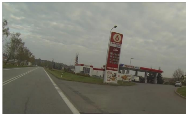
Obrázek 29: Totem čerpací stanice pohonných hmot (staničení 177,539 km)
