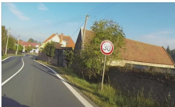
Obrázek 19: Neexistující chodník (staničení 142,085 km)
