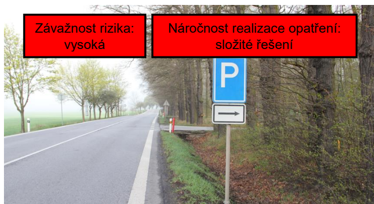
Obrázek 70: Tuhé čelo trubního propustku pod sjezdem (NL Libějovice)
