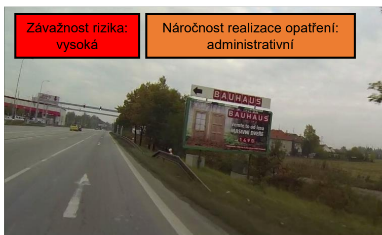
Obrázek 33: Reklamní zařízení na nedeformovatelné konstrukci
