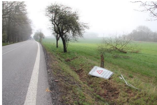
Obrázek 63: Poškozené SDZ A 22 „Jiné nebezpečí“ (NL Libějovice)
