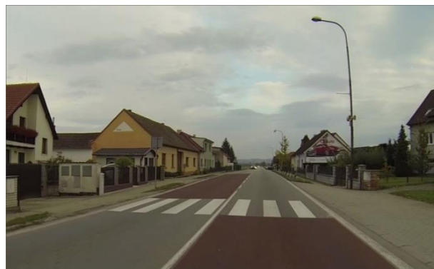
Obrázek 18: Neadekvátní provedení VDZ, absence prvků pro OOSPO, absence osvětlení (staničení 205,911 km)
