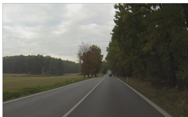
Obrázek 27: Charakter komunikace a okolí umožňuje předjíždění vozidel, při zachování adekvátní úrovně bezpečnosti silničního provozu II (staničení 191,989 km)
