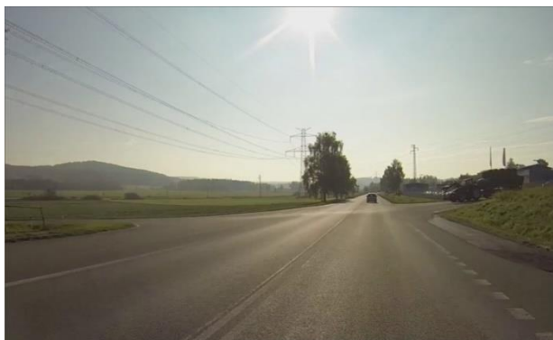
Obrázek 7: Rozlehlá křižovatka, neadekvátní usměrnění dopravy a absence nebo opotřebované VDZ (staničení 174,076 km)
