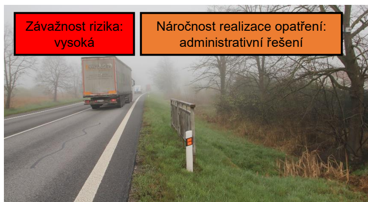
Obrázek 91: Tuhé čelo trubního příčného propustku II (NL Pištín)
