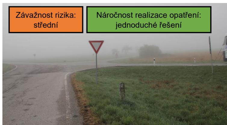
Obrázek 92: Betonový sloupek (NL Pištín)
