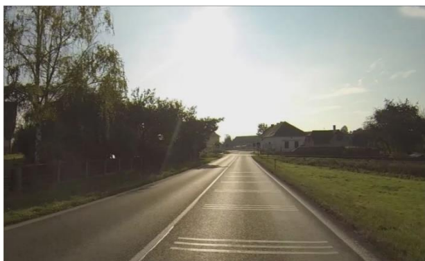
Obrázek 13: Nevhodné provedení VDZ V 18 (staničení 132,282 km)
