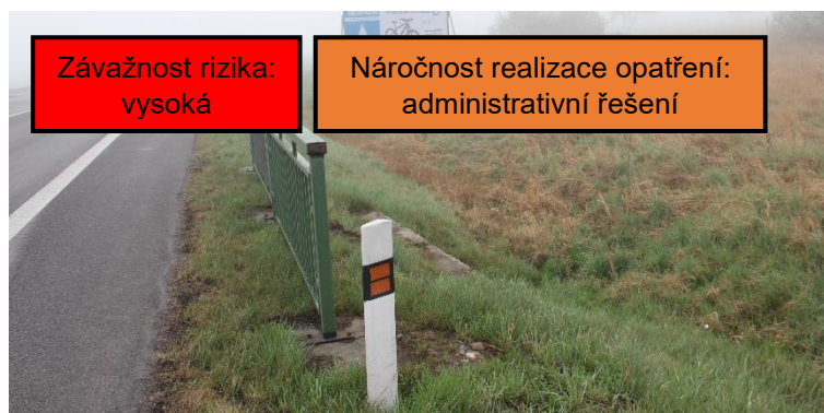
Obrázek 90: Tuhé čelo trubního příčného propustku I (NL Pištín)
