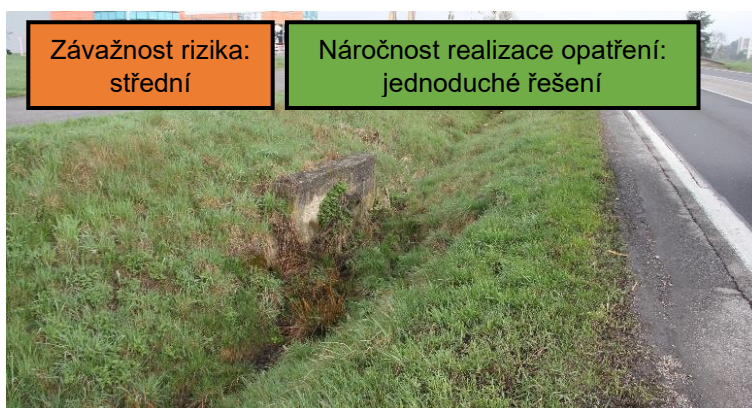
Obrázek 46: Tuhé čelo trubního příčného propustku (NL Protivín)
