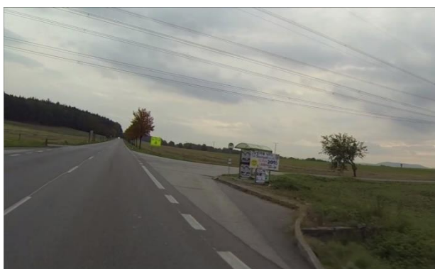
Obrázek 15: Absence VDZ V 11a, V 12a. Záliv autobusové zastávky zasahuje do prostoru křižovatky. Neadekvátní délka vyřazovacího úseku (staničení 188,095 km)
