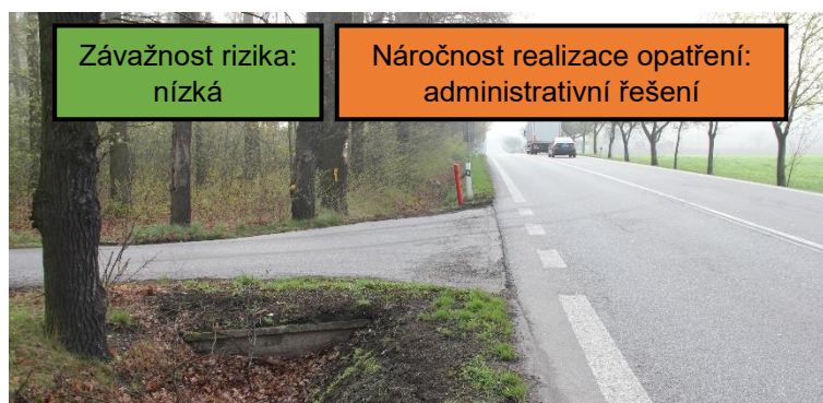
Obrázek 74: Neadekvátní provedení dopravního zařízení (NL Libějovice)
