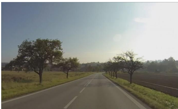
Obrázek 9: Neadekvátní stav SDZ a VDZ – absence SDZ B 21a a VDZ V 9b (staničení 129,151 km)
