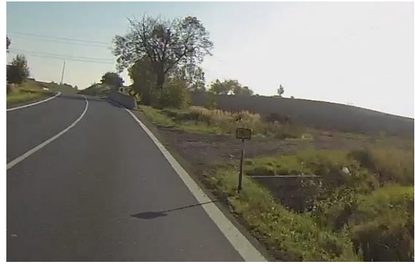
Obrázek 4: Tuhé čelo trubního propustku pod – sjezdem / samostatným sjezdem (staničení 153,913 km)
