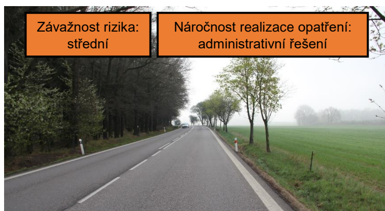
Obrázek 75: Absence zpevněné krajnice (NL Libějovice)
