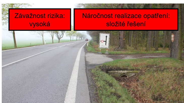
Obrázek 69: Tuhé čelo trubního propustku pod sjezdem (NL Libějovice)
