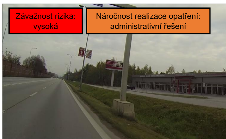
Obrázek 34: Dopravní značení na nedeformovatelné konstrukci
