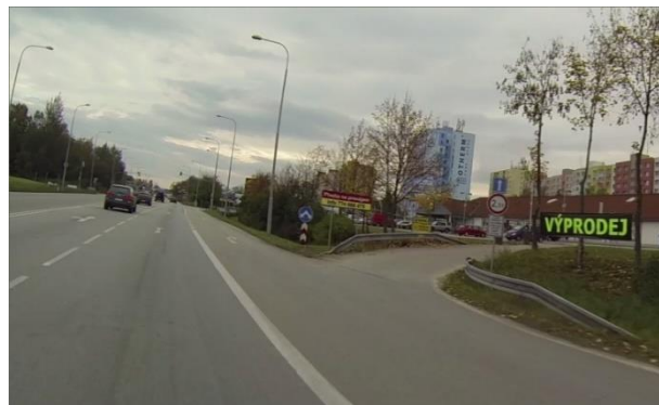
Obrázek 12: Absence VDZ V 2b v místě sjezdu (staničení 210,174 hm)
