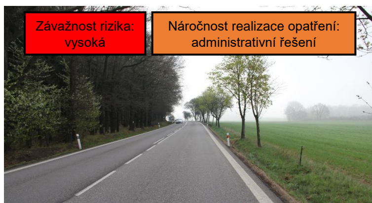
Obrázek 71: Absence SDZ B 21a a VDZ V 9b (NL Libějovice)
