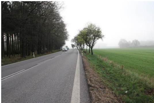
Obrázek 62: Pohled na směrový oblouk (NL Libějovice)
