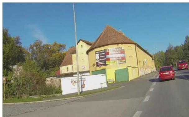
Obrázek 20: Chodník vůči vozovce v neadekvátní výškové poloze (nedostatečně vyvýšený), neadekvátně realizované místo pro přecházení (např. Poloha, provedení), chybějící místo pro přecházení (staničení 138,306 km)
