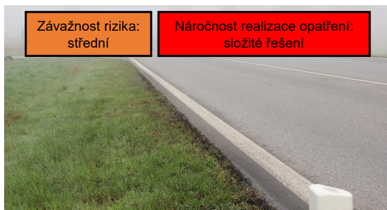
Obrázek 99: Absence zpevněné krajnice (NL Pištín)
