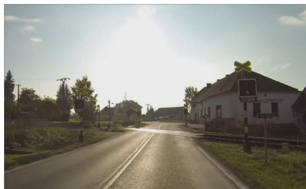
Obrázek 14: Neadekvátní rozhledové poměry v místě železničního přejezdu (staničení 132,511 km)
