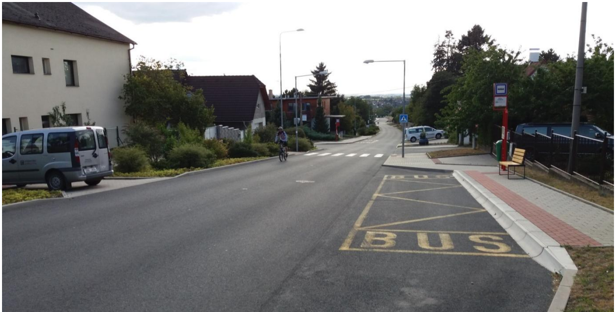
Obrázek 88 – nově zrekonstruovaný úsek ul. Olivova v okolí autobusové zastávky Pivoňková
