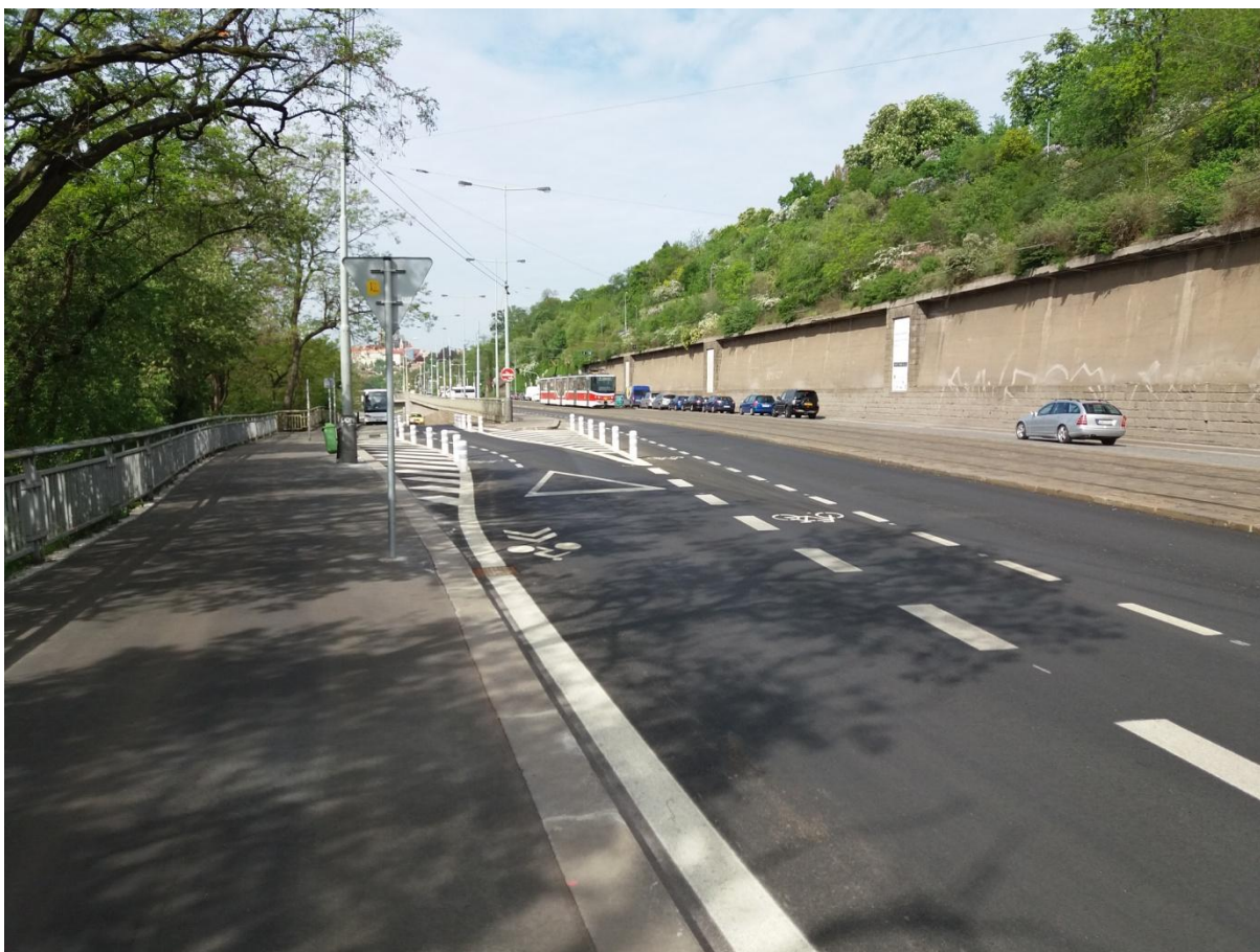
Obrázek 34 - Výjezd z podjezdu pod Štefánikovým mostem, většina cyklistického pohybu se odehrává na chodnících
