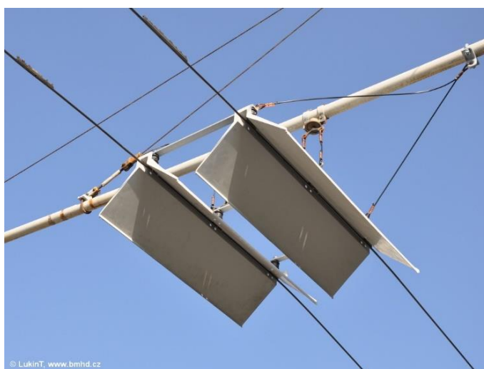
Obrázek 15: Natrolejovací stříšky pro parciální trolejbus (zdroj: Brněnská MHD, 2018)
