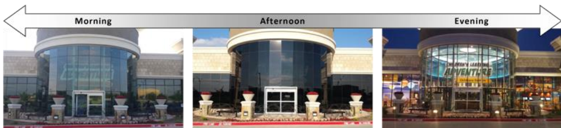
Obr. 12: Ukázka termocitlivého povlaku naneseného na skleněných plochách nákupního centra a její chování v různých denních dobách. [40]
