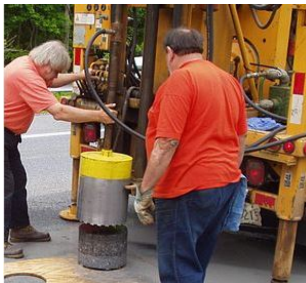
Obr. 40: Jádrové vrtání [12]
