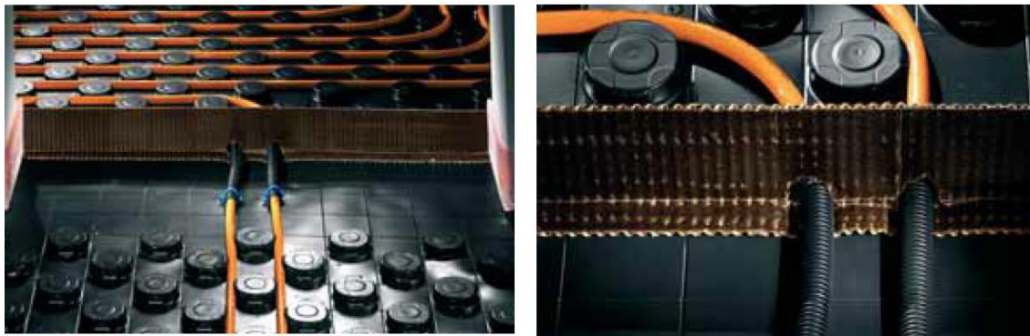
Obr. 5.8 Provedení dilatačních spár
