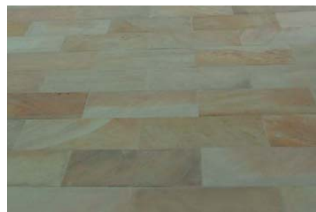
5_PARKOVÉ CHODNÍKY kamenná dlažba - pískovec odstín: žluto-šedá dlaždice 200 x 1250 x 50mm tryskaný povrch obruba: dlaždice na úzkou hranu do betonu
