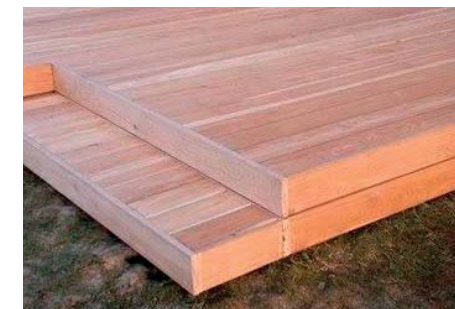
12_PĚŠÍ PLOCHY dřevěná palubka - tropické dřevo odstín: přirozená, patina lamely šířky 160mm hoblovaný povrch se zářezy, přesné hrany obruba: přirozená (další dlažba)
