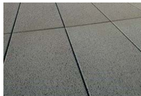
9_PĚŠÍ PLOCHY betonová velkoformátová dlažba odstín: světle šedá dlaždice 600 x 300 x 60mm hlazený povrch, přesné hrany obruba: přirozená (objekty, vozovky, další dlažba)
