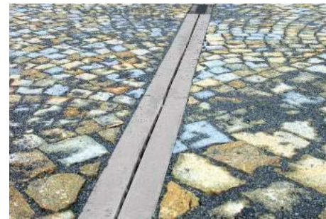
K2_BETONOVÝ ŠTĚRBINOVÝ ŽLAB materiál: beton barva: šedá uliční vpusť dešťové vody - liniová
