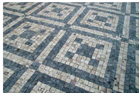
3_CHODNÍKY V CENTRU kamenná dlažba - pražská kostka odstín: mozaika barev kostky 60 x 60 x 60mm štipané, popř. tryskané obruba: přirozená (objekty, vozovky, další dlažby)
