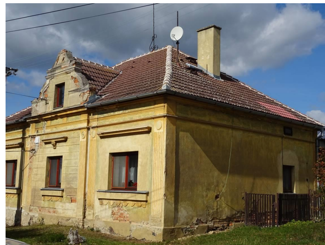
Obrázek 90 Venkovská zástavba č. p. 142 - Broumy
