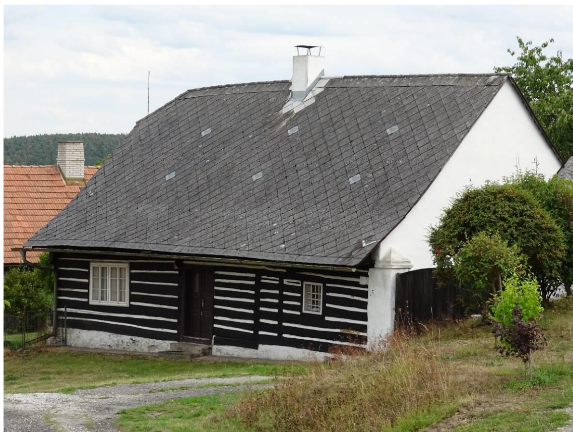
Obrázek 16 Venkovská stavba Jungmannova 19 – Hudlice [zdroj: autor, 2018]
