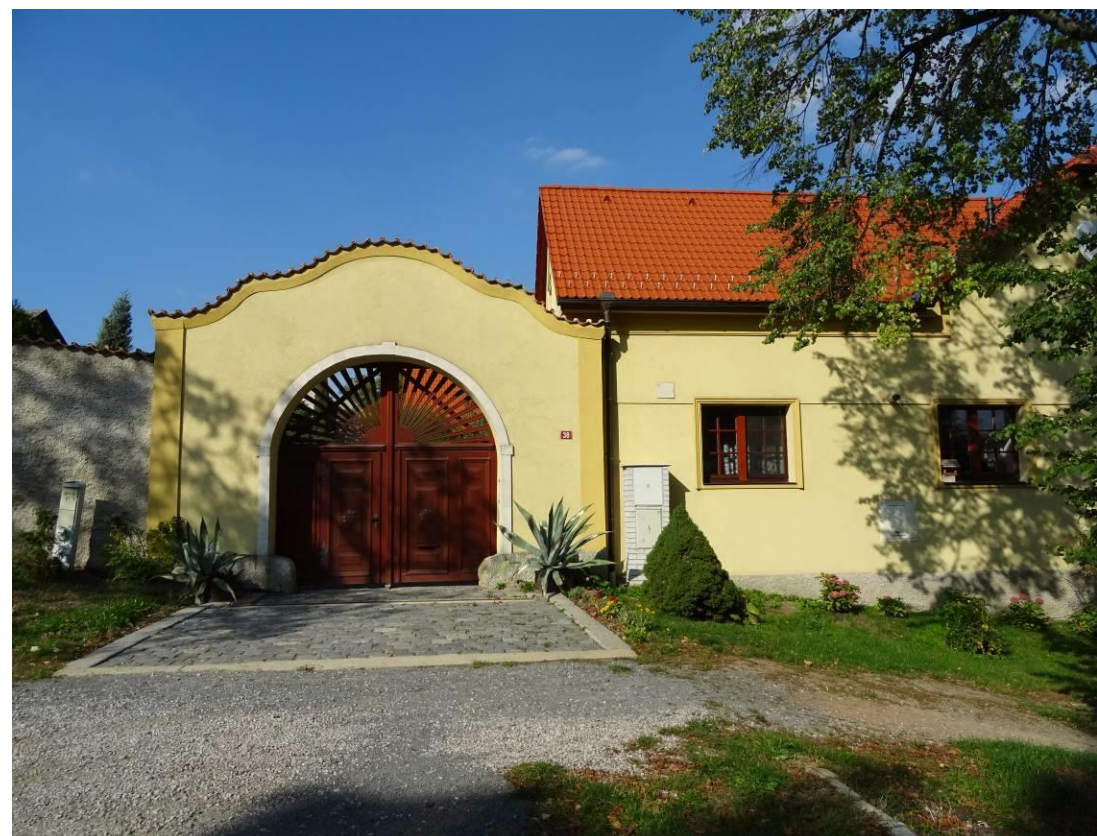
Obrázek 72 Původní zástavba - Na Vršíčkách - Hudlice
