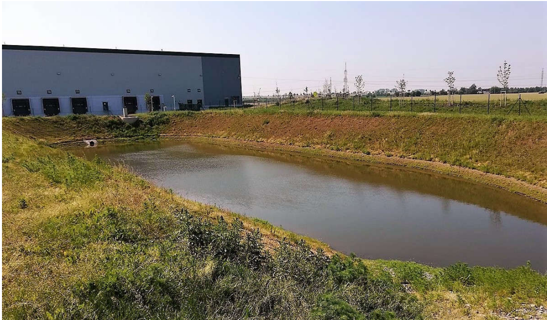
Obrázek 27 - Příklad suché retenční nádrže, vyfotografováno těsně po přivalovém dešti, Prologis Park Jirny
