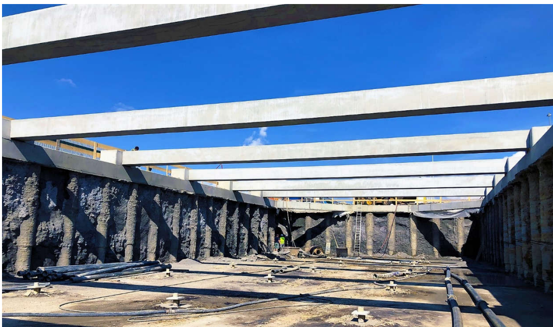
Obrázek 26 - Příklad betonové retenční nádrže Prologis Park Jirny
