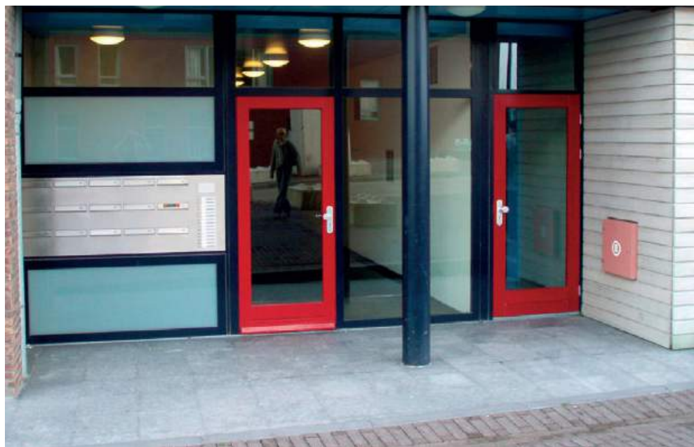
příklad správného řešení vstupu do domu, bez výškových rozdílů, vhodný materiál na povrchu přístupové cesty a u vstupu, prostor před vstupem s dostatečnou manipulační plochou pro pohyb, rovný a dobře osvětlený, zastřešený, schránky v dosahu osoby na vozíku
