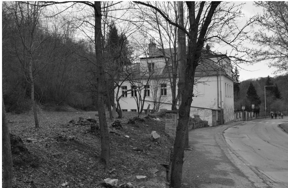
chodníky a komunikace jsou ve špatném stavu
