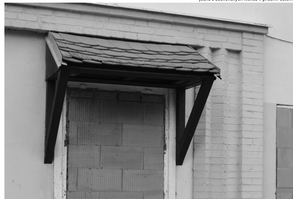
dochovaná profilace fasády na středním křídle
