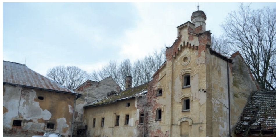
jihovýchodní fasáda hvozdvé věže a obytné budovy
