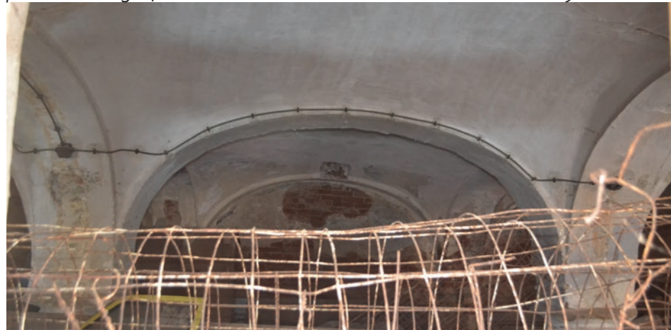
placková klenba v interiéru
