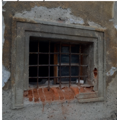
obdélné okno s kamenným ostěním
