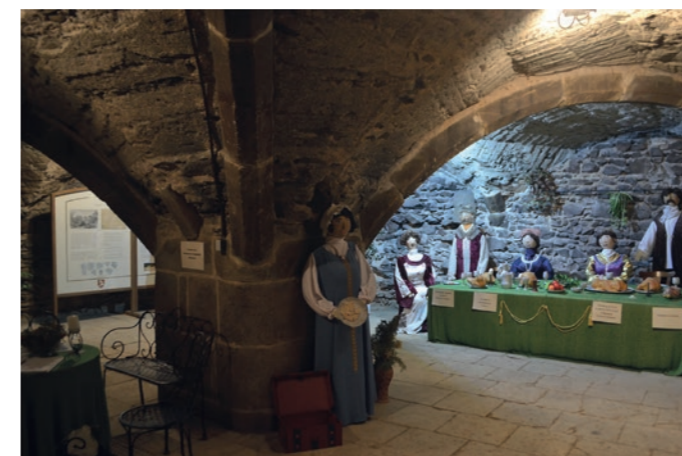
křížová kamenná klenba s pětibokými žebry
