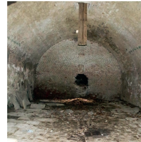
valeně klenutý sklep
