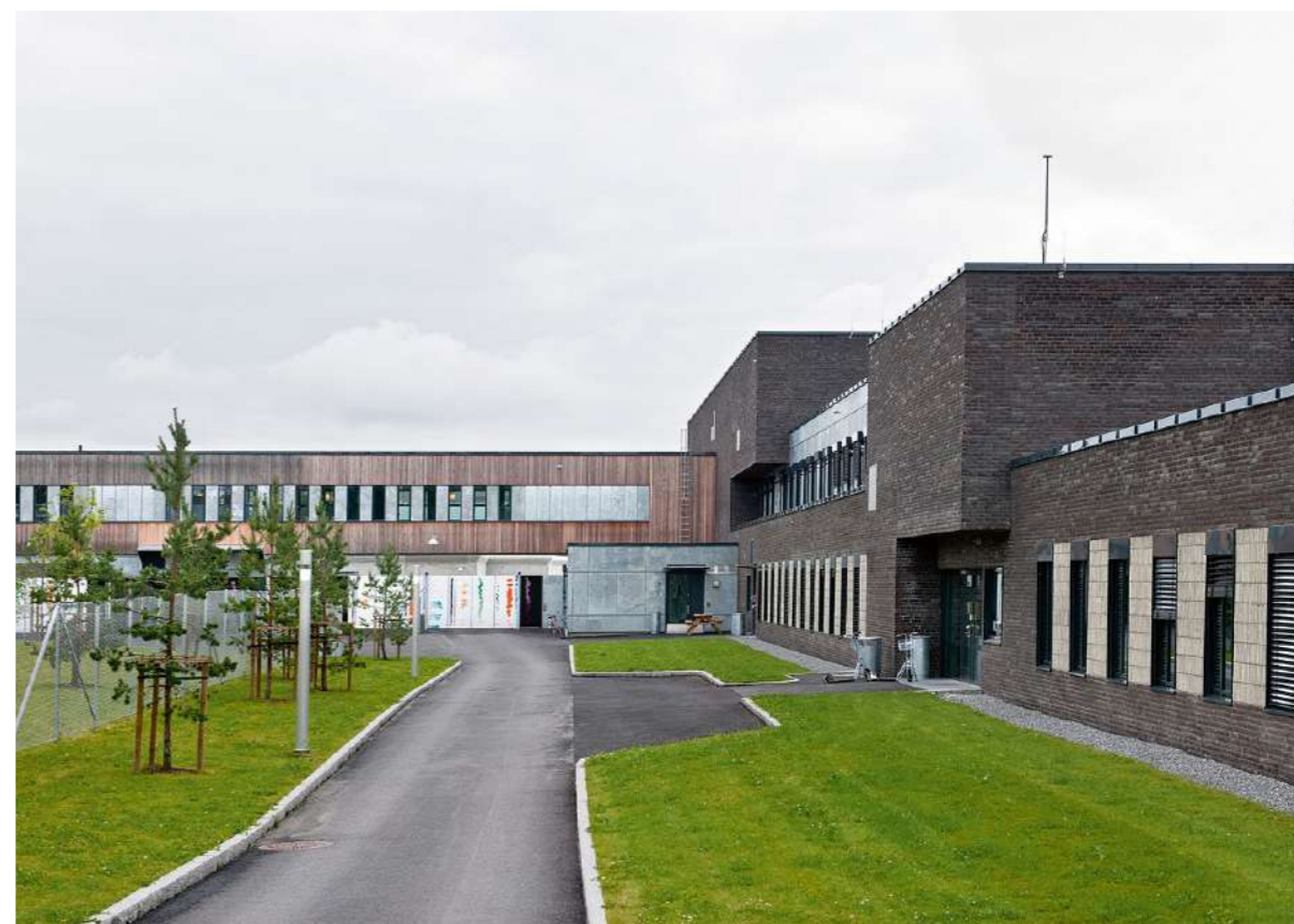
Pohled od hlavního vstupu do areálu věznice
