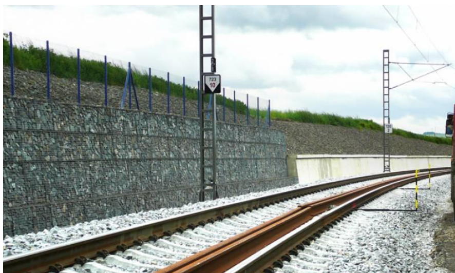
obr. 17: Zárubní zeď z gabionů a betonu
