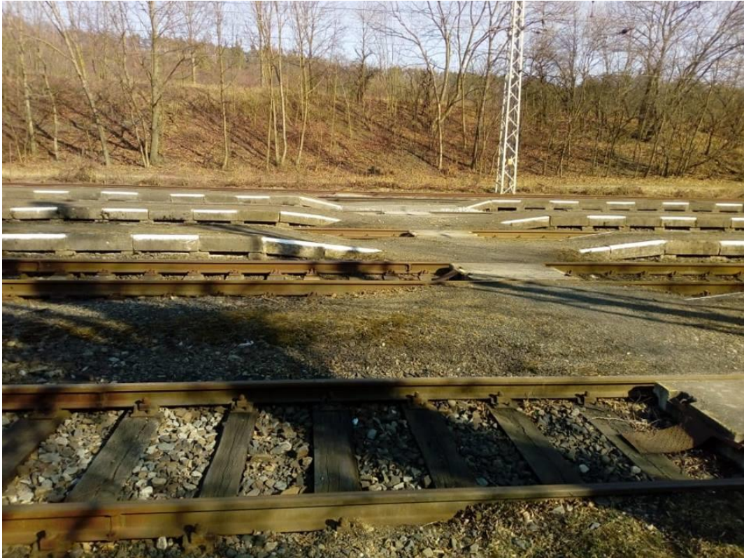
Pohľad na staničné koľaje a prístup na úrovňové nástupišťa (v popredí dopravná koľaj č. 5)
