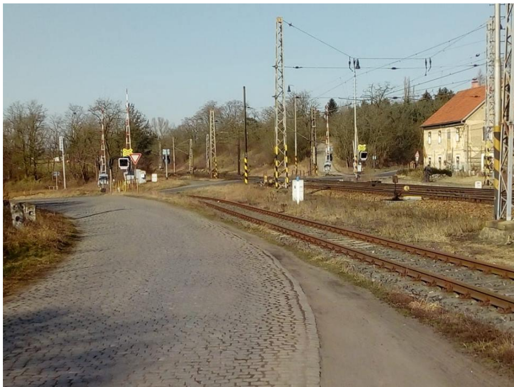
V popredí vlečka Mondí Štětí a. s. a pohľad na výhybku č. 18. V pozadí železničný prejazd P2948 – 3ZNI vľavo od DK v smere na autobusovú zastávku Štětí, železniční přejezd
