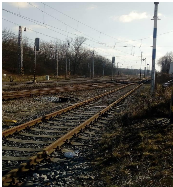
Pohľad v smere od hošteckého zhlavia na odchodové návěstidlá v smere na Hoštku, v popredí vlečka Mondí Štětí a. s.
