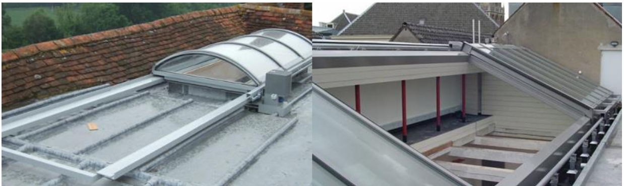
Obr.3.: Příklady posuvných krytů používaných jako kryty střech [Zdroj: [18 a 19]]
