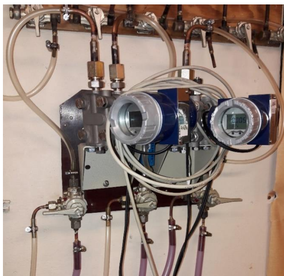
Obrázek 25 Snímače tlakové difference
