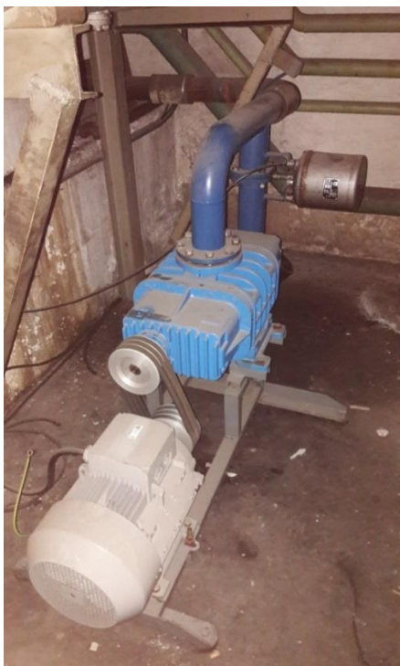
Obrázek 23 Dmyhadlo poháněné elektromotorem
