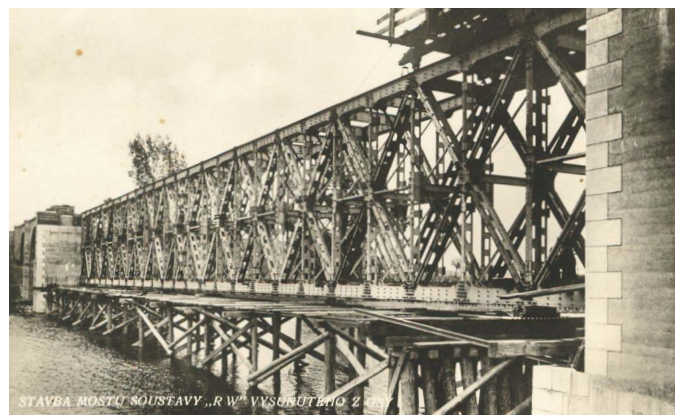
Stavba mostu na lešení - spodní uložení
