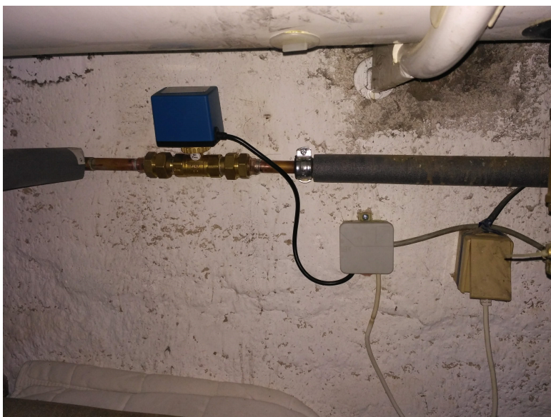
Obrázek 10.3: Zapojení dvoucestného ventilu.
