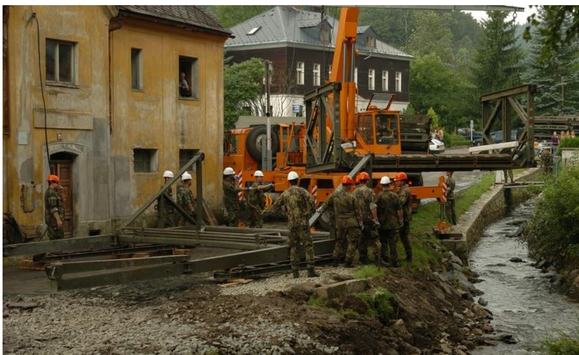
Obrázek 3 Stavba provizorního mostu při povodních [54]
