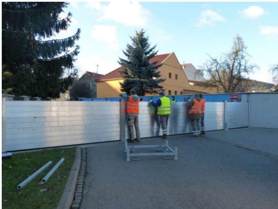
Stavění protipovodňových hrází v lokalitě Na Ostrově
