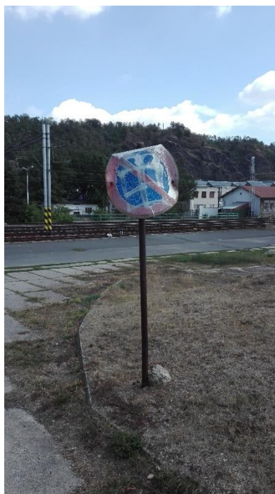
Obrázek 30. Poškozená dopravní značka zákazu stání (foto: ČENĚK, Tomáš)
