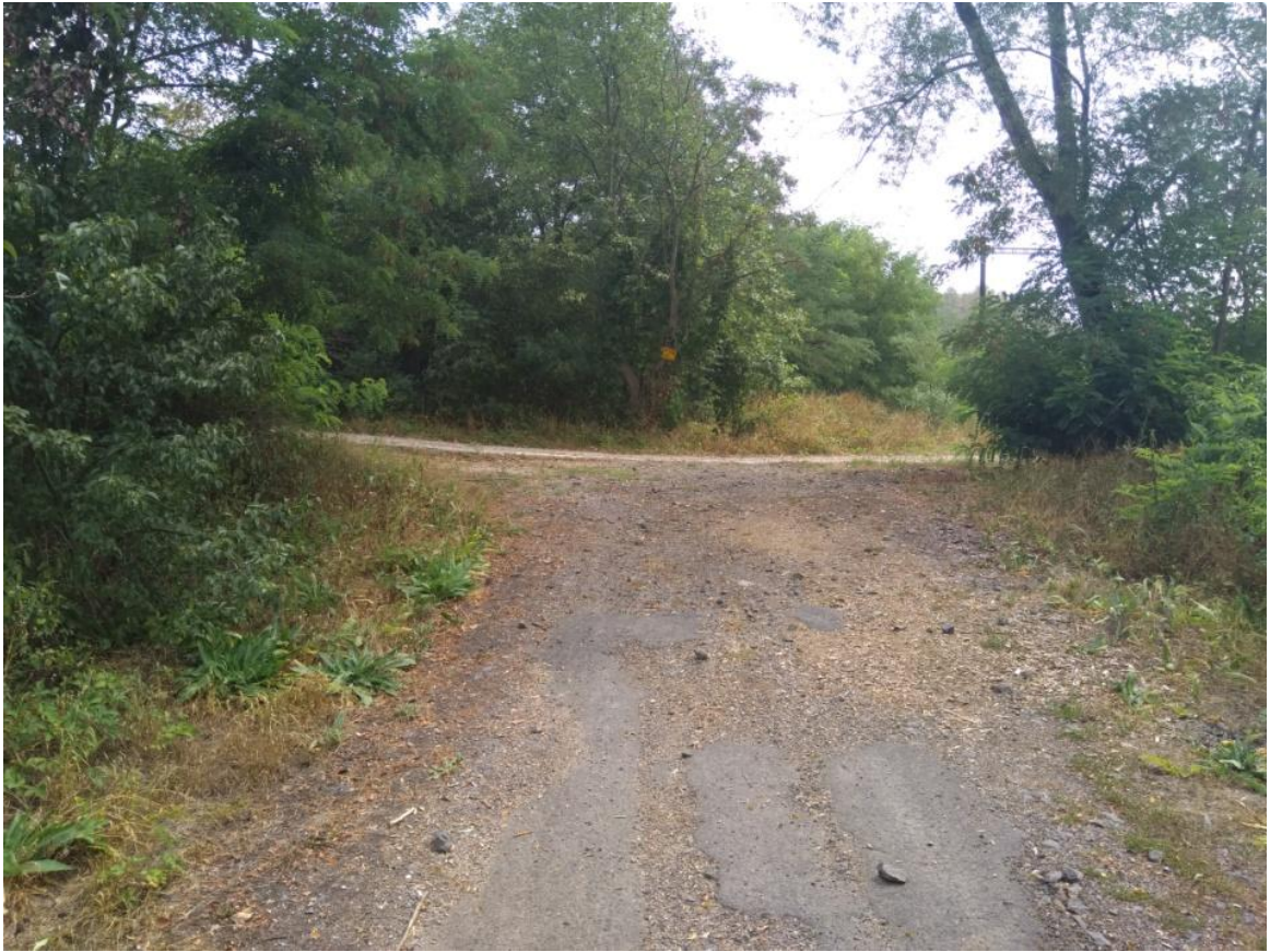
Obrázek 4 - Změna povrchů z asfaltu na betonové panely, [vlastní zpracování]
