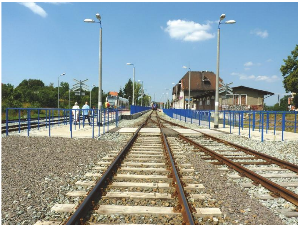
Obrázek 15 - Příklad poloostrovního nástupiště s bezpečnostním zábradlím, [12]
