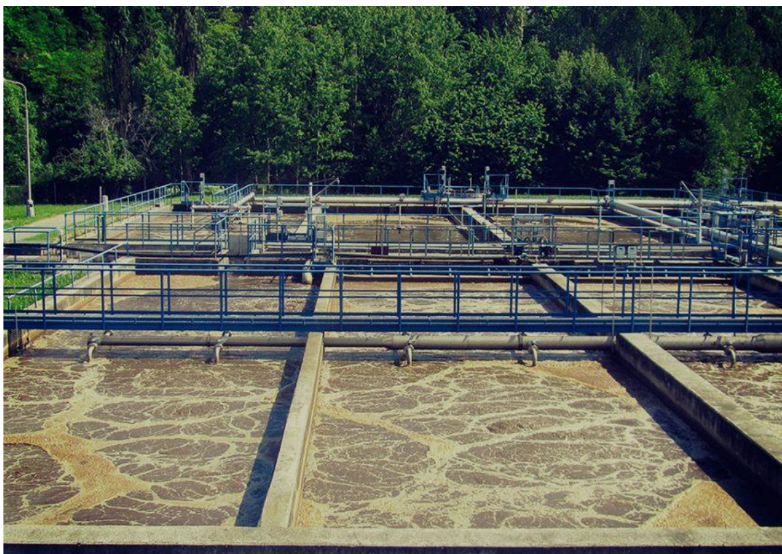
Obrázek č. 10: Čistírna odpadních vod [14]
