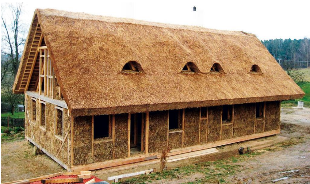
Obrázek č. 9: Dřevěná konstrukce zateplená slámou [13]
