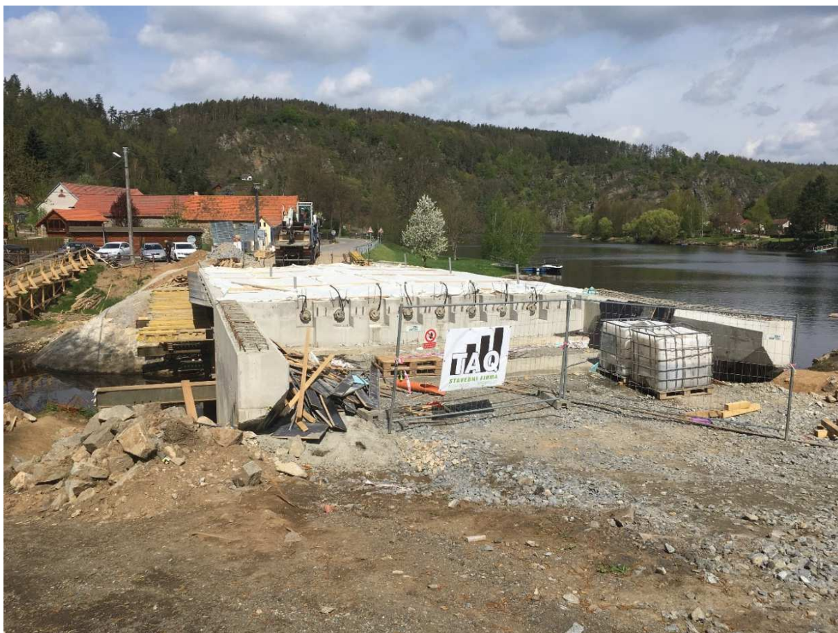
Obr. 7 ukázka předpjatého deskového most ev. č. 102-02
