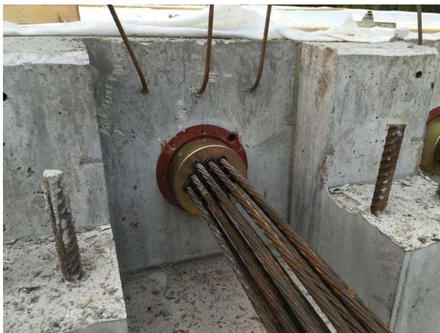
Obr. 8 předpínací kabel v deskovém mostě ev. č. 102-028
