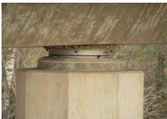
Obr. 11 Bodové podepření konstrukce s hrncovým ložiskem
