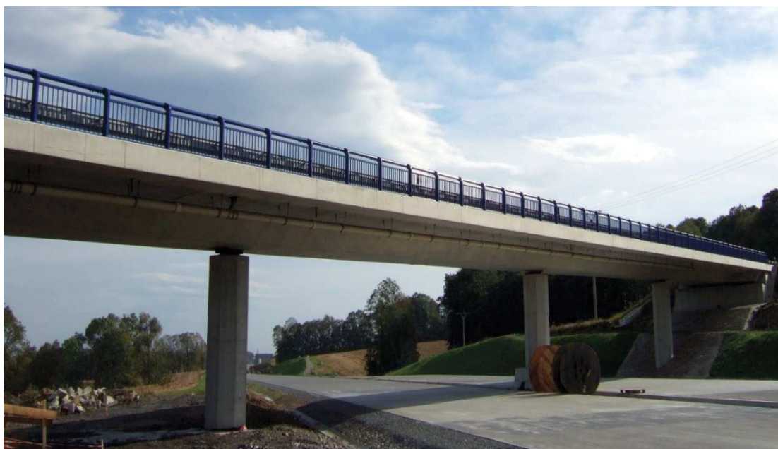
Obr. 10 Příklad bodového podepření konstrukce
