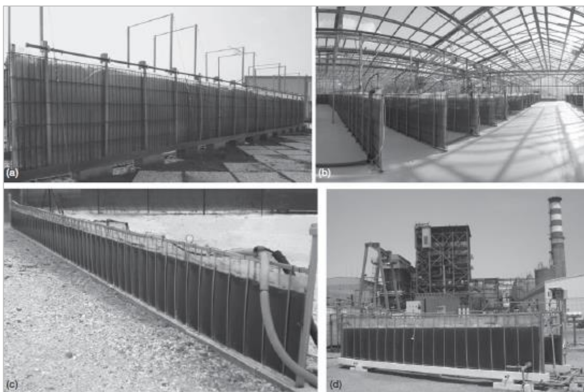
Obr. 38 -Flexibilné panely. (a) 10 m dlhý GWP prvej generácie; (b) moduly GWP-I (1000 m 2 ) v prevádzke v Taliansku; (c) 12 m dlhý GWP druhej generácie; (d) GWP-II v prevádzke pri elektrárni Empresa Electrica del Norte Grande SA (Čile) [7]
