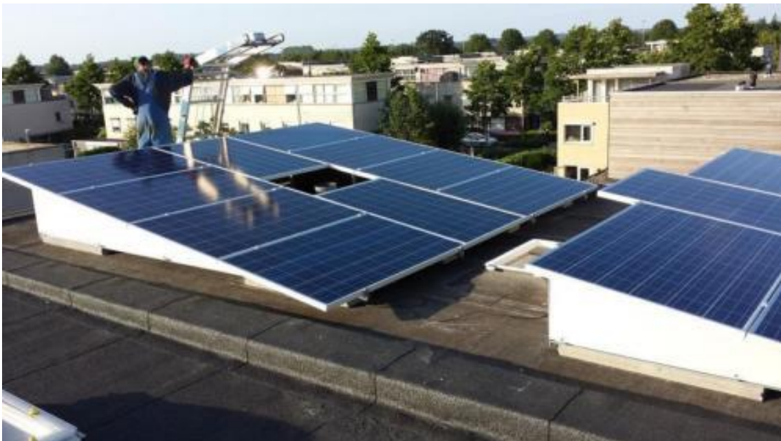
Obrázek 10 Možná instalace solárního panelu Canadian Solar 280 Wp [10]
