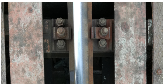
Obr. 8: Přímé upevnění s rozponovou podkladnicí
