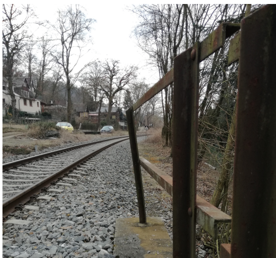
Obr. 21: Vychýlené zábradlí
