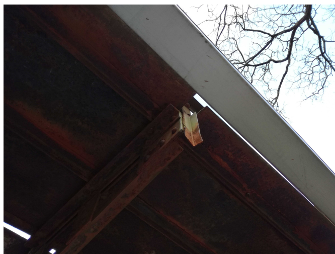
Obr. 22: Zvlněná část držáku pro uložení žlabu
