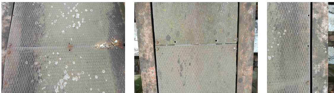
Obr. 19: Chybějící šrouby v podlahách
