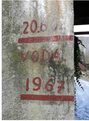
Obr. 13: Vyznačené výšky hladin povodní na opěře O 01
