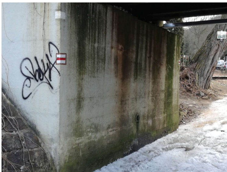
Obr. 4: Pohled na opěru O 02
