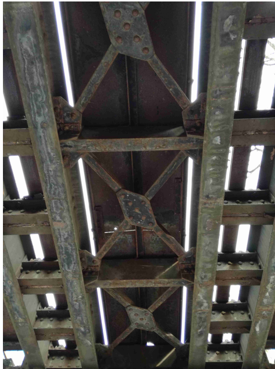
Obr. 5: Pohled na nosnou konstrukci zdola
