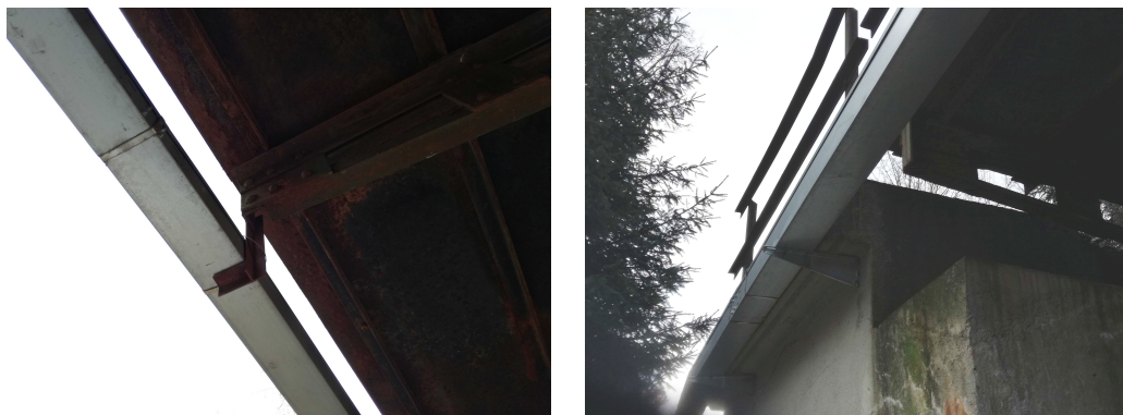
Obr. 12: Detail uložení žlabu
