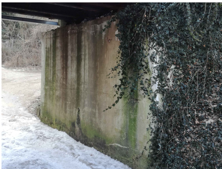
Obr. 3: Pohled na opěru O 01
