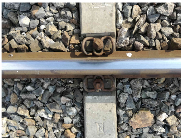
Obr. 9: Upevnění typu W 14
