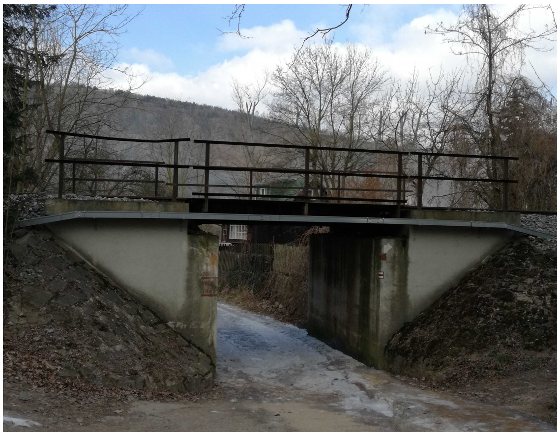
Obr. 1: Pohled na most zprava
