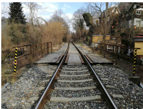
Obr. 10: Pohled ve směru staničení
