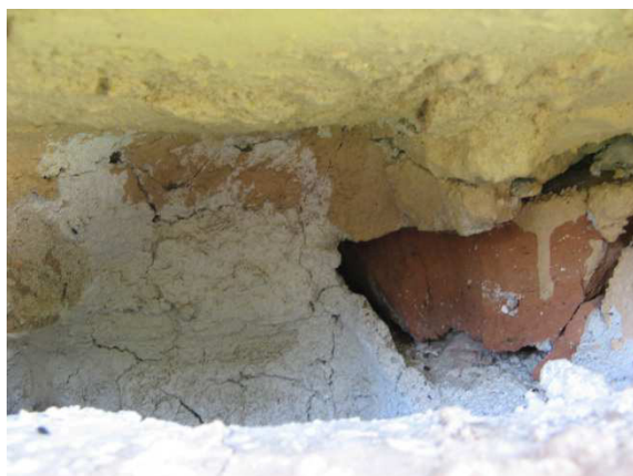
Obr. 23 Pohled na stěnu výdechového otvoru, povrch vyhlazen maltou
