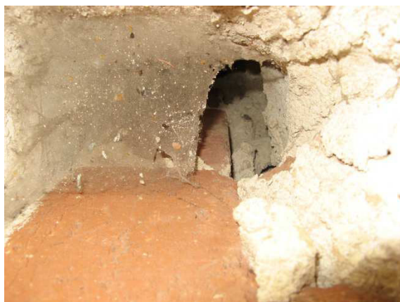
Obr. 24 Pohled shora do výdechového otvoru
