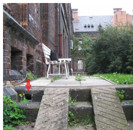
Obr. 11 Schodiště s nasávacím otvorem „N1“
