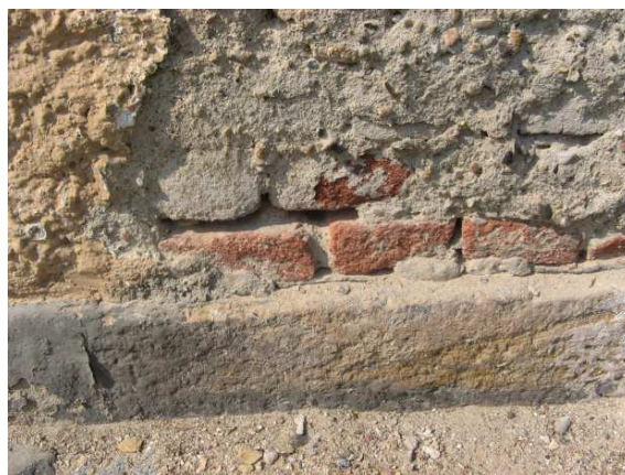
Obr. 20 Fasáda – obnažení cihelného zdiva
