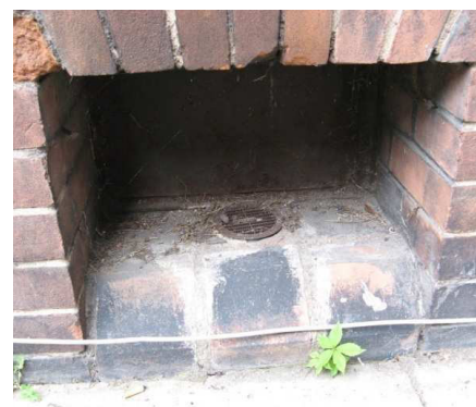
Obr. 13 Výdechový otvor kanálu v parapetu okna
