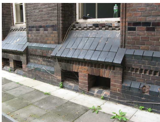
Obr. 8 Pohled na severní fasádu křídla G4 se vzduchovým kanálem a sklepním okénkem
