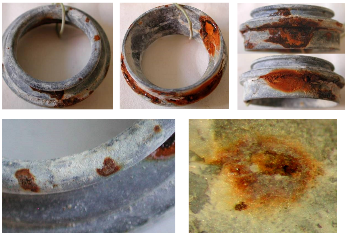
Obrázek 116- Korozní napadení vzorku N5 po 2016 h expozice v NSS
