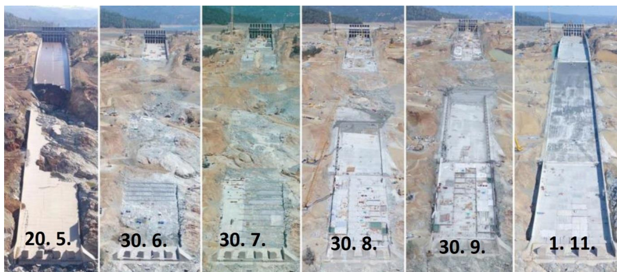
Obr. 7. Časový postup prací na rekonstrukci přelivu v roce 2017 [7].
